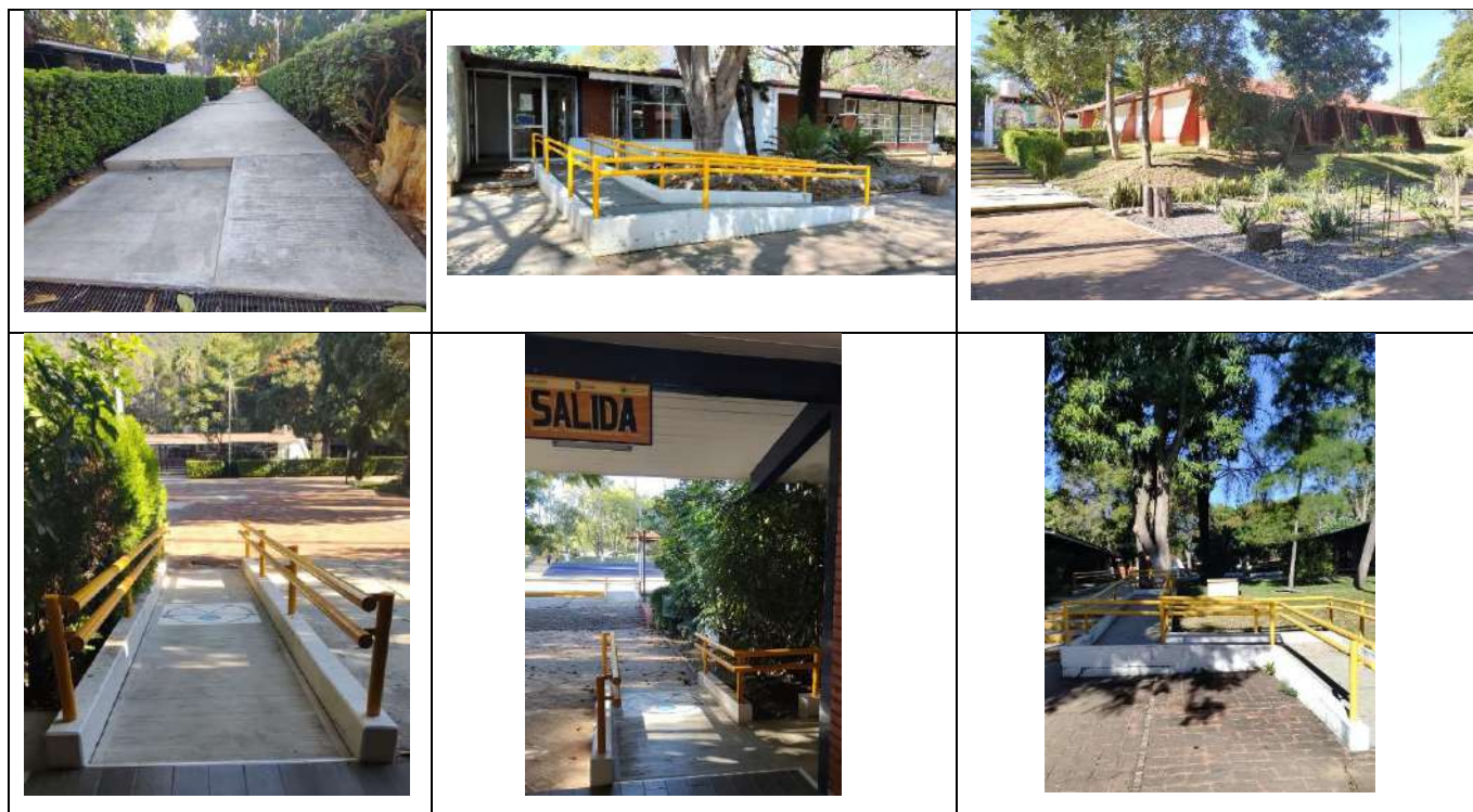
Figura 1. Rampas de acceso a pasillos, aulas y laboratorios.
