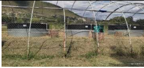
Tanques de acero inoxidable con geomembrana.
