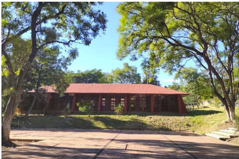
Figura 2. Exterior de la biblioteca
